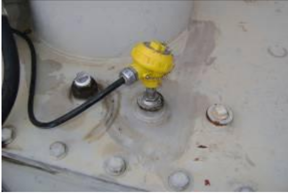
Fig. 5. Pt100 para medição da temperatura do óleo
