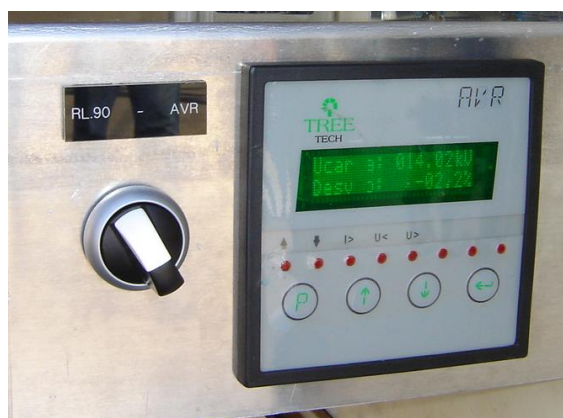
Figura 5 – Chave Seletora para o AVR fuzzy ou Relé 90 convencional.
