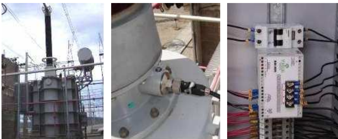
Figura 4 – Detalhes do sistema para monitoração das buchas [3]
