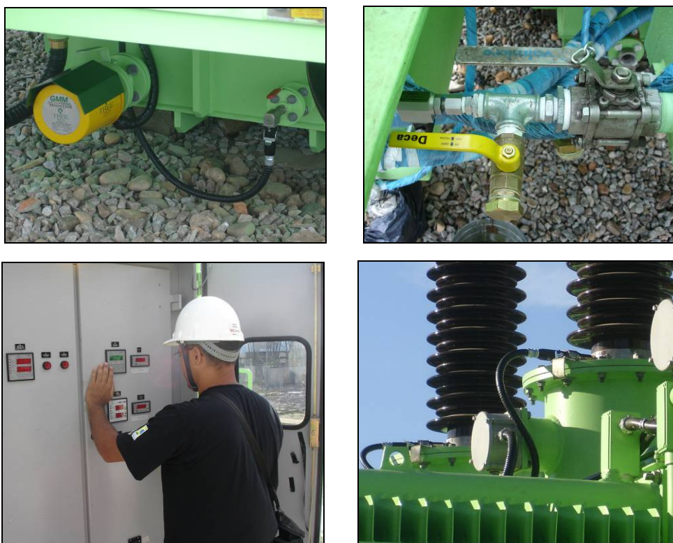
Figura 05 - Instalação dos sensores no transformador
