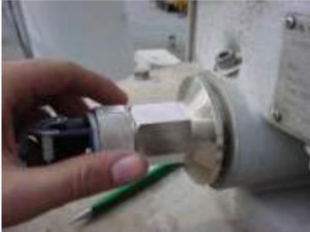
Figura 7 - Instalación del adaptador de tap.
