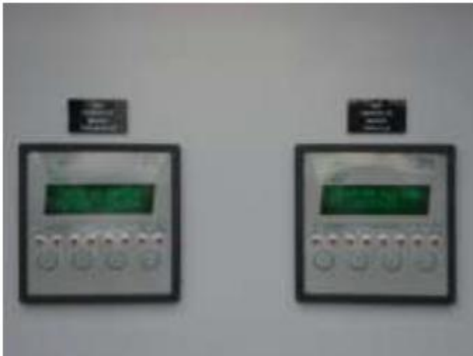
Figura 9 - Instalación de los módulos de interfaz.
