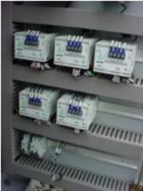
Figura 8 - Instalación de los módulos de medición.
