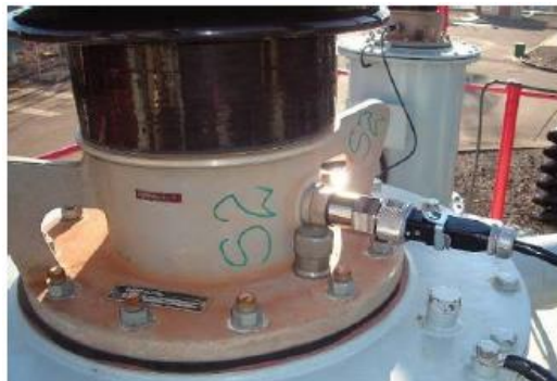
Figura 4 – Conexión directa del sistema de monitoreo al tap de bushing al lado [5]
