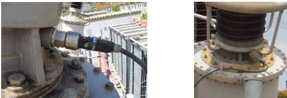
Figura 1 - Exemplo de instalação de adaptadores de tap. Fonte: [7].
