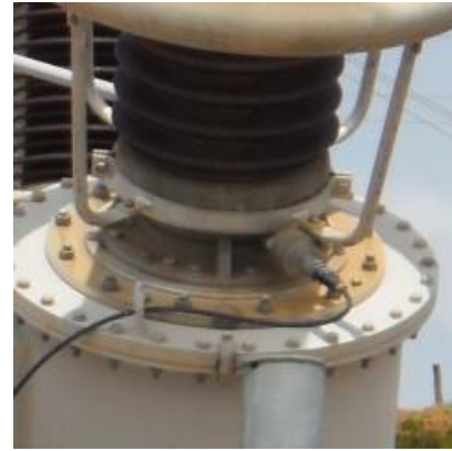
Figura 2 - Ejemplo de instalación de adaptadores de tap. Fuente: [7].
