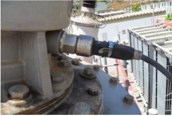
Figura 2 - Ejemplo de instalación de adaptadores de tap. Fuente: [7].
